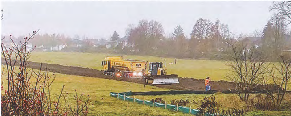
Der Bagger kam am Montag, um eine Baustraße zur geplanten Kita-Baustelle zu verlegen. FOTO: PRIVAT
