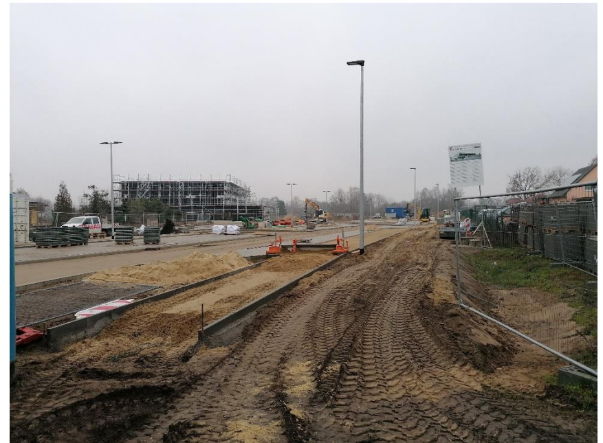
Baustelle des zukünftigen Grundschulstandortes mit 2-Feld-Turnhalle (Dez 2020)
